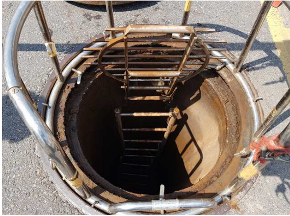
내용 안전손잡이, 사다리 상태양호
