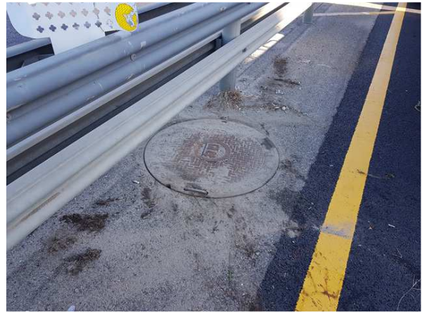
내용 맨홀 외부 전경 상태양호
